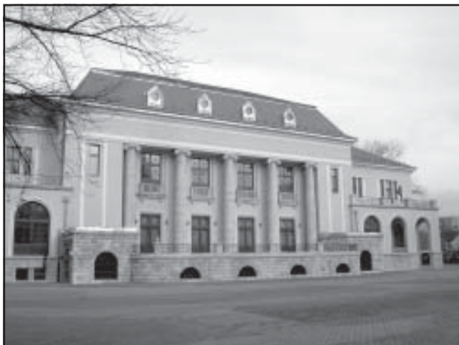
A felújított művelődési ház
